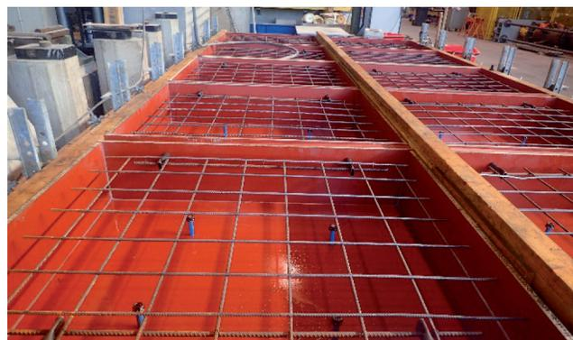
Figura 1. Encofrado de las losas de hormigón y anclajes
